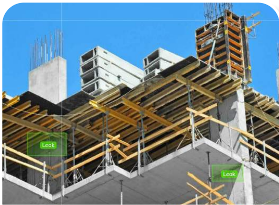
(d) Structural defect detection
