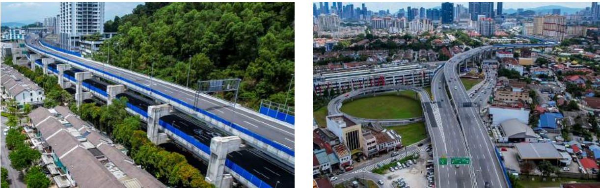
Figure 5.26 The Projek Penswastaan Lebuhraya Bertingkat Sungai Besi - Ulu Kelang (SUKE)
